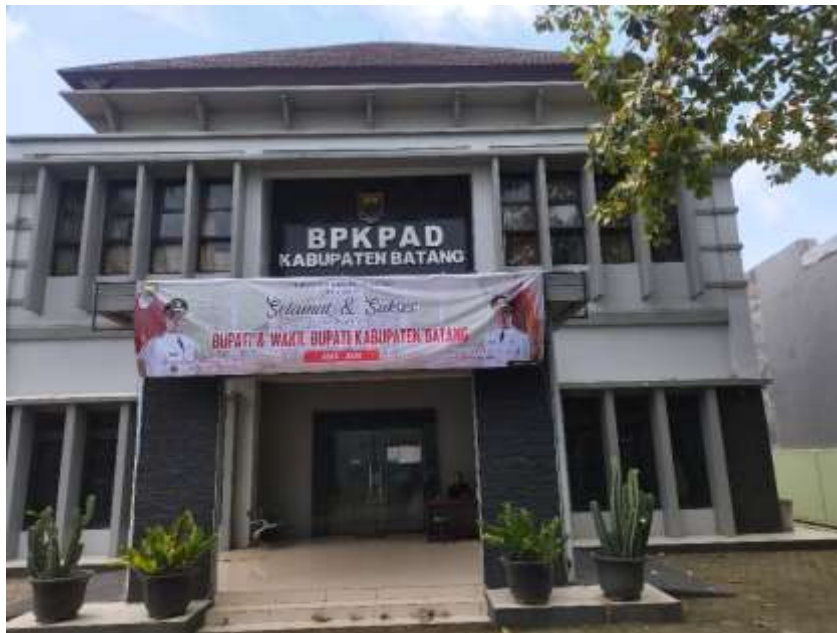
Gambar 2. 1 Kantor BPKPAD Kabupaten Batang
