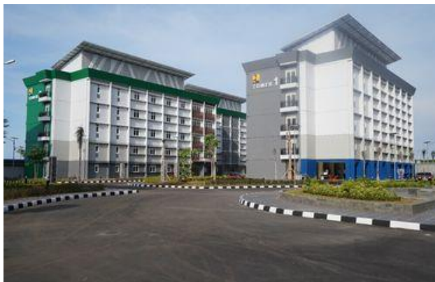
Gambar 2.28 Rusunawa Pekerja KITB
