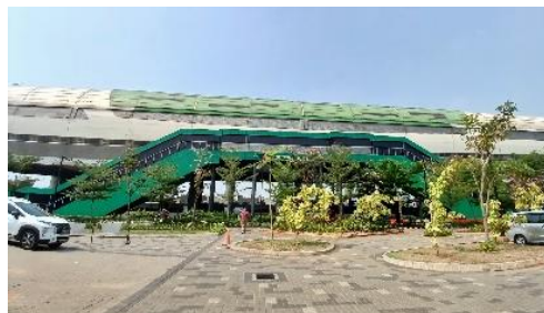
Gambar 2. 6 Stasiun LRT Jati Mulya (Sumber: Dokumentasi Pribadi, 2024)
