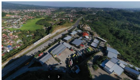
Gambar 2. 6 Kondisi Sekitar Rest Area KM 429 A Tol Ungaran-Bawen
