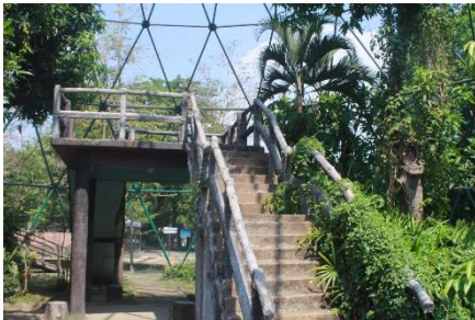
Gambar 2. 26. Kondisi Eksisting Bird Dome
