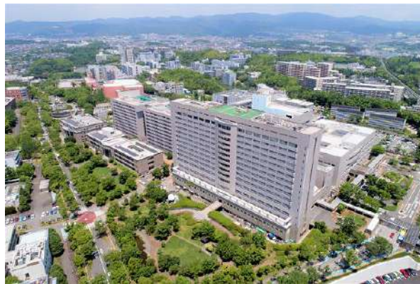
Gambar 3. 7 Bangunan Osaka University Hospital (sumber: hosp.med.osaka-u.ac.jp/ )
