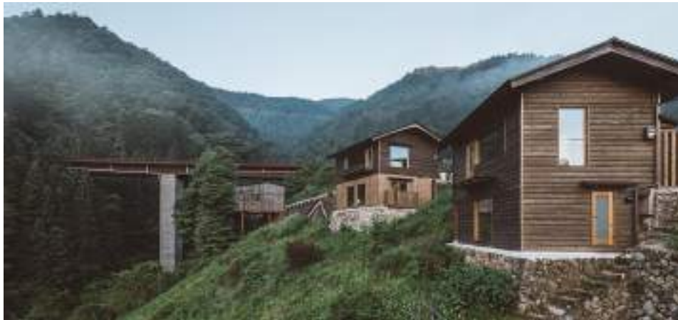
Gambar 3.8 : Beberapa bangunan kamar hotel yang dahulunya merupakan akiya. (sumber: openers.jp)
