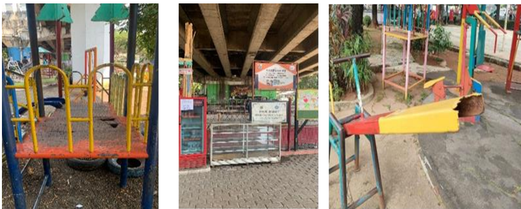
Gambar 1.1 Rusaknya Fasilitas RPTRA
