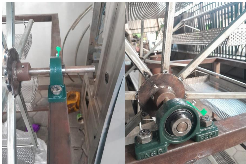
Gambar 4. 12 Proses Fabrikasi Pemasangan Bearing pada Poros
