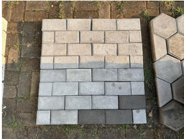
Gambar 3. 22 Susunan Paving block Segi Empat
