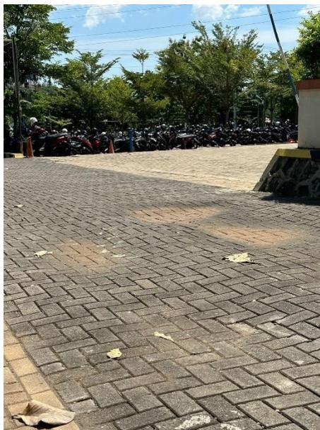
Gambar 1. 2 *Paving block* Mengalami Lendutan pada Area Parkir Kendaraan Bermotor
