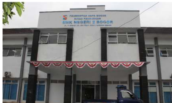
Gambar 12. Bangunan SMKN 2 Bogor
