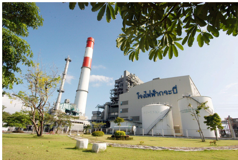
Gambar 2.5. Pembangkit Listrik Berkapasitas 315 Megawatt di Provinsi Krabi
