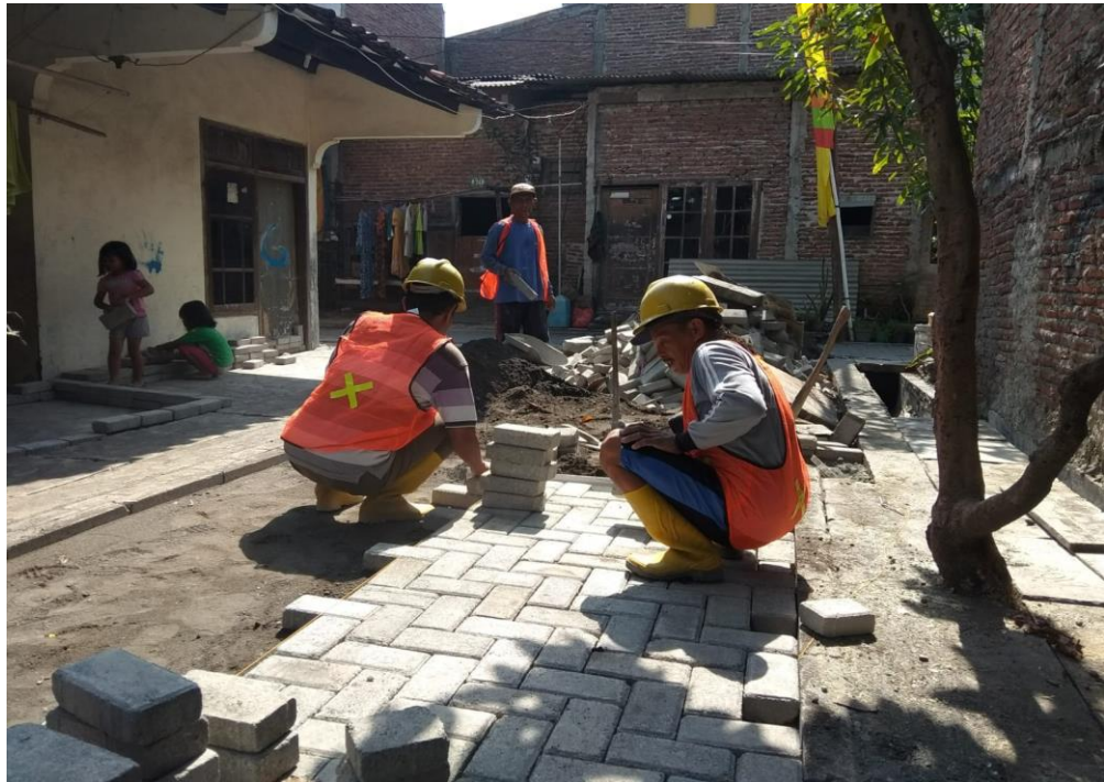
Gambar 2.4 Kegiatan Pembuatan Jalan Paving Block Sumber: Dokumentasi Pelaksanaan Progam KOTAKU Bandarharjo
