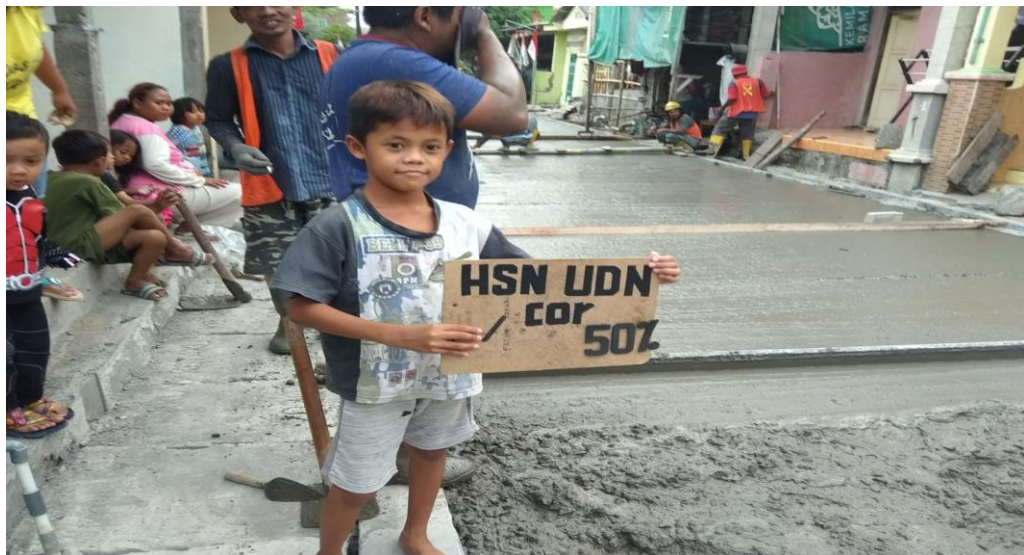
Gambar 2.3 Pembangunan Jalan Beton Kelurahan Bandarharjo, Kec. Semarang Utara
