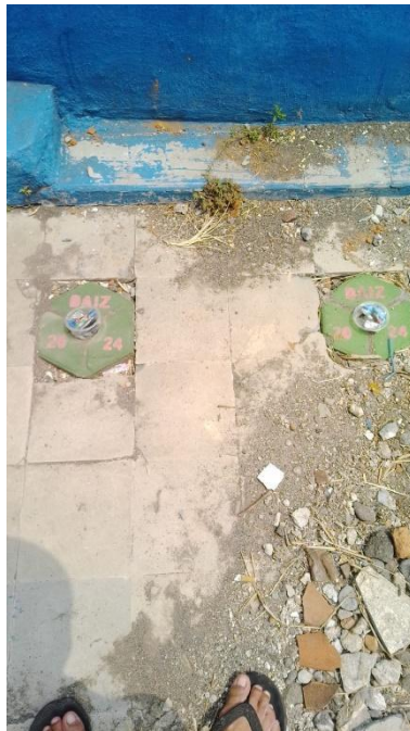
Gambar 3.3 Fasilitas Biopori untuk pengolahan sampah organik di bank sampah resik 06
