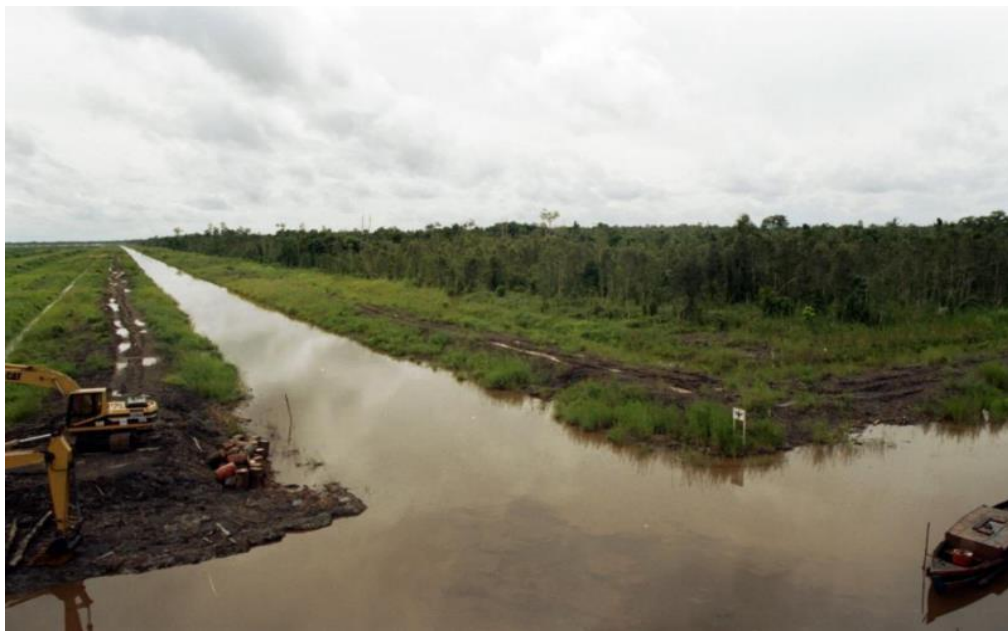
Gambar 2.1 Proses Pembangunan Kanal dan Pembukaan Lahan Gambut Mega Rice
