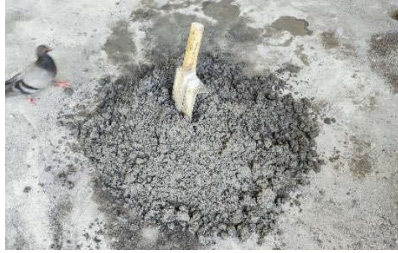
Gambar 3. 29 Mengaduk Bahan Hingga Homogen
