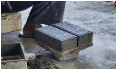
Gambar 3. 31 Paving Block Setelah Dicetak
