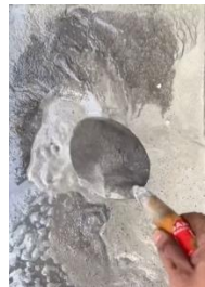
Gambar 3. 43 Memasukkan foaming agent Sumber : Dokumentasi Pribadi
