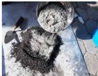
Gambar 3.18 Mencampurkan Pasir dan Semen
