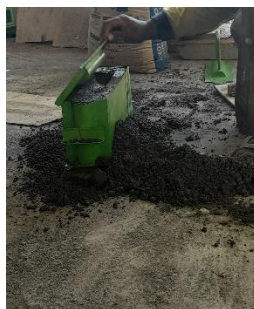
Gambar 3. 39 Proses cetak batako interlocking
