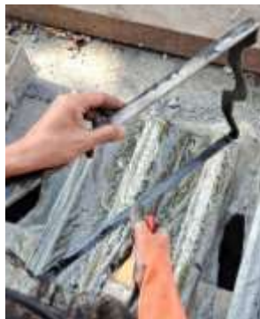
Gambar 3. 66 Memasang Mal Besi (Sumber : Dokumentasi Penulis)
