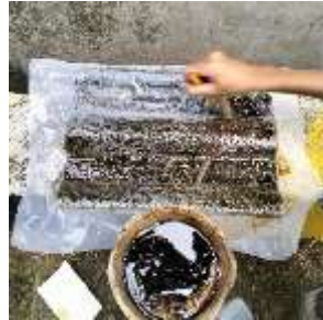
Gambar 3. 65 Mengoleskan Oli Pada Plastik Cor (Sumber : Dokumentasi Penulis)
