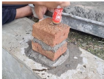
Gambar 3. 15 Pengaplikasian Permukaan Ke Dua Mortar Dan Bata
