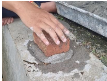
Gambar 3. 14 Pengaplikasian lapisan bata pertama pada mortar
