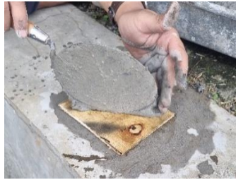
Gambar 3. 13 pengaplikasian Mortar ke permukaan plywood
