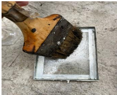
Gambar 3. 27 Pengolesan Minyak bekisting
