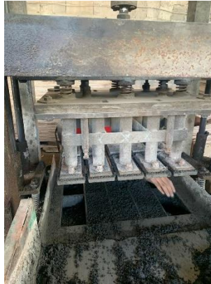
Gambar 3. 35 Proses penuangan adonan paving block kedalam cetakan
