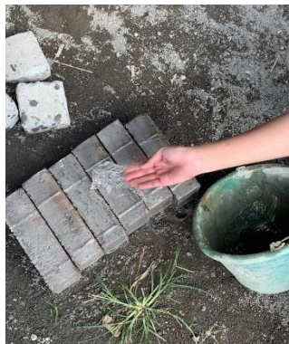
Gambar 3. 38 Proses penyiraman paving block
