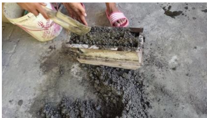
Gambar 3.46 Pencetakan Bata Beton
