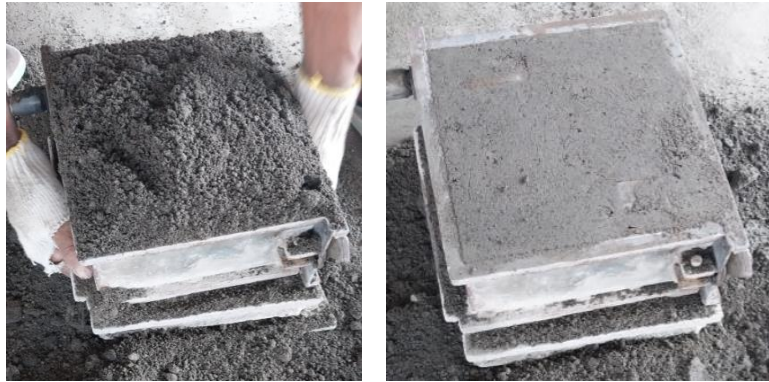
Gambar 3.51 Pencetakan Ventilation Block
