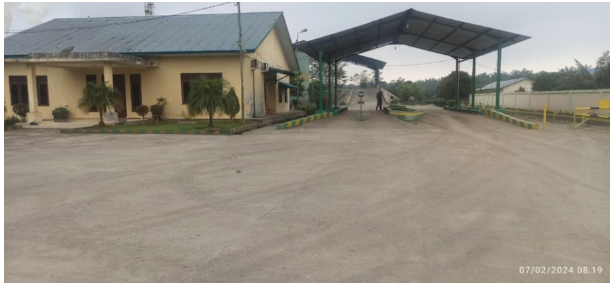
Gambar 1. Tampak depan perusahaan
