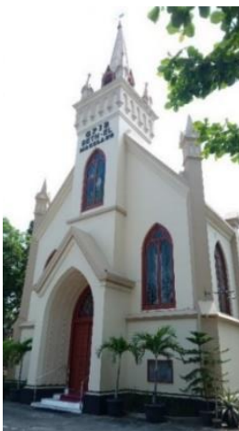
Gambar 2.6. Kondisi Gereja GPIB Beth-El Sumber : Koleksi Foto Pribadi
