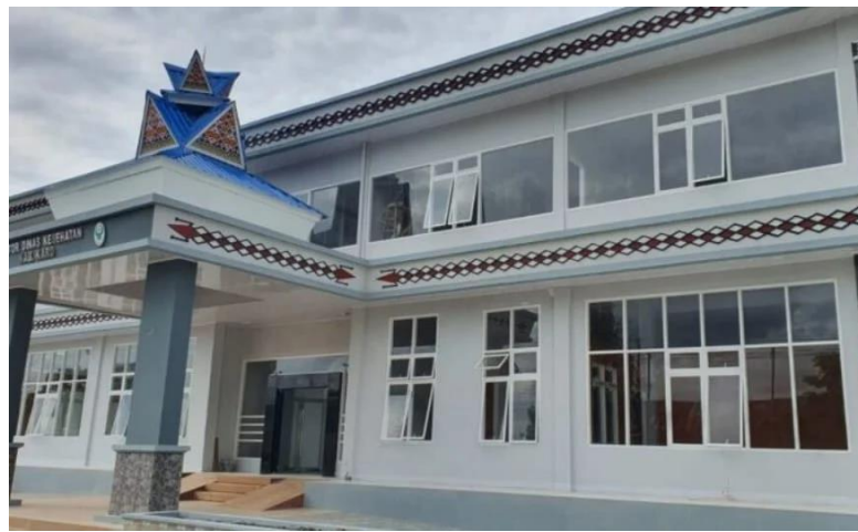
Gambar 2. 2 Gedung Dinas Kesehatan Kabupaten Karo
