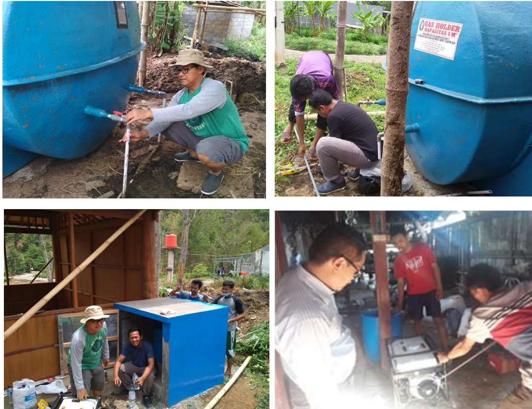
Gambar 6. Setting pipa pada tabung penyimpanan biogas dan persiapan penempatan genset
