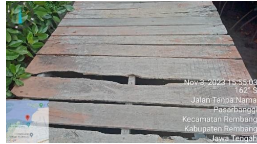
Gambar 1. 4 Beberapa Bagian Jembatan Berlubang
