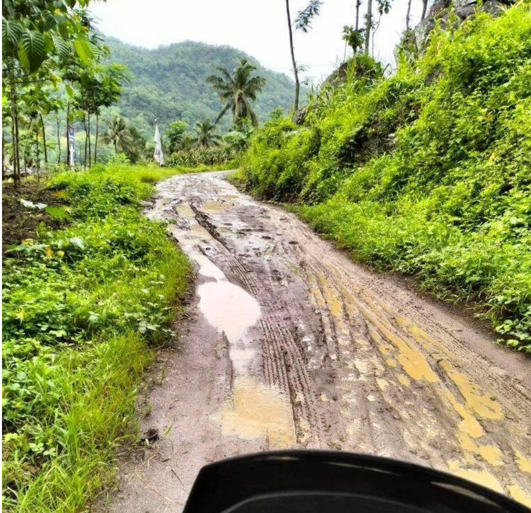
Ruas Jalan Cening-Kaliputih yang belum dibangun
