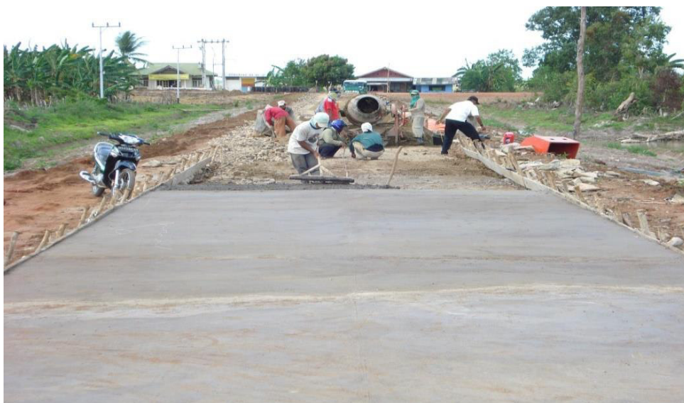
Gambar 1.5. Pekerjaan pembangunan jalan dari pasir galian - material lokal Merauke ( rigid pavement – sand cement )
