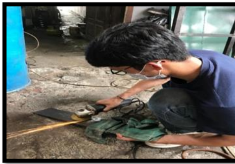
Gambar 3. 4 Proses pembersihan karat yang terdapat pada benda uji dengan gerindra.
