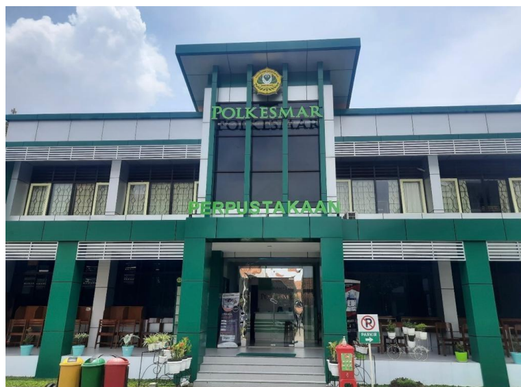
Gambar 2.2 Gedung Perpustakaan Poltekkes Kemenkes Semarang
