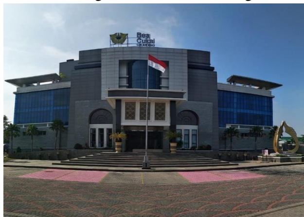
Gambar 2.1 Gedung KPPBC TMP Cikarang
