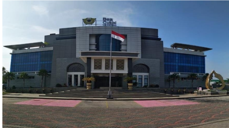
Gambar 2.1 Gedung KPPBC TMP Cikarang
