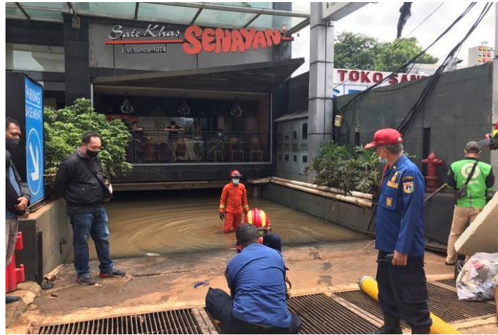
Gambar 2. 1 Banjir Basement (Konstruksi Bawah Tanah)
