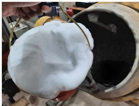
Gambar 3. 44 Masukkan Busa ke dalam Concrete Mixer (Sumber : Dokumentasi Penulis)
