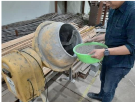
Gambar 3. 39 Memasukkan Pasir ke dalam Concrete Mixer (Sumber : Dokumentasi Penulis)
