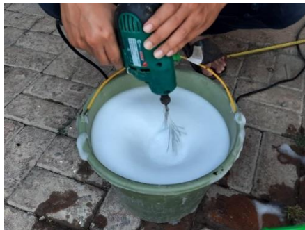
Gambar 3. 37 Pencampuran Air dengan Foam (Sumber : Dokumentasi Penulis)
