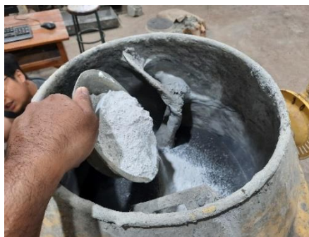
Gambar 3. 41 Memasukkan Kapur Tohor ke dalam Concrete Mixer (Sumber : Dokumentasi Penulis)
