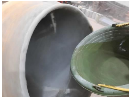
Gambar 3. 43 Memasukkan Air ke dalam Concrete mixer (Sumber : Dokumentasi Penulis)
