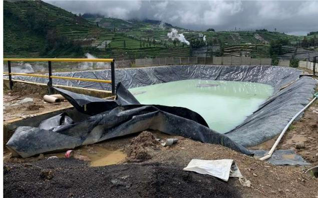
**Gambar 1. 1** Konstruksi Kolam (Pond) dengan Geomembrane
