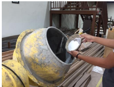
Gambar 3. 35 Memasukkan Serbuk Tiram ke dalam Concrete Mixer
