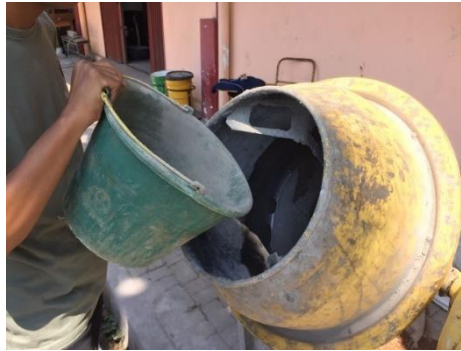
Gambar 3. 34 Memasukkan Pasir ke dalam Concrete Mixer
