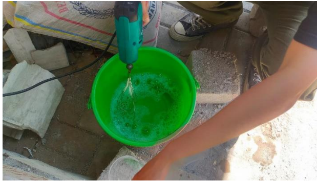
Gambar 3. 32 Pencampuran Air dan Foam Agent dengan Mixer
