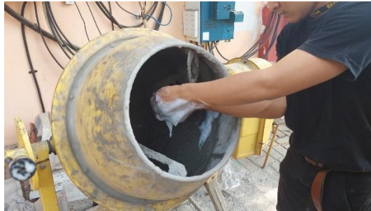
Gambar 3. 37 Proses Menambahkan Foam ke dalam Concrete Mixer
