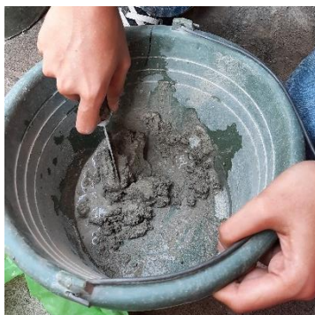
Gambar 3. 13 Menyiapkan Mortar Untuk Bahan Perekat
