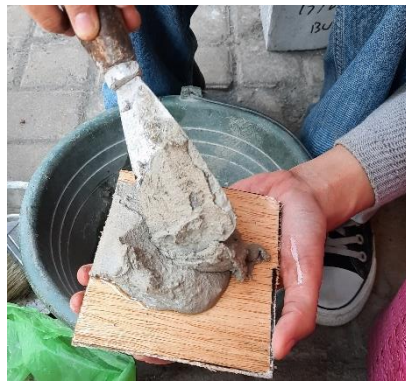
Gambar 3. 16 Melapisi Plywood dengan Mortar
