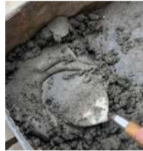
Gambar 3. 62 Proses Pembuatan Adukan Beton
