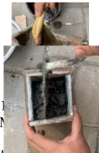
Gambar 3. 63 Proses Penuangan Adukan Beton Pada Bekisting
