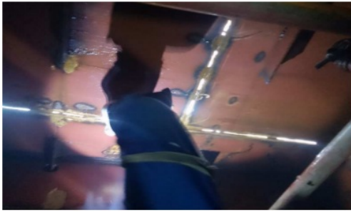
Gambar 5. Pengukuran gap sebelum joint Erection Block
