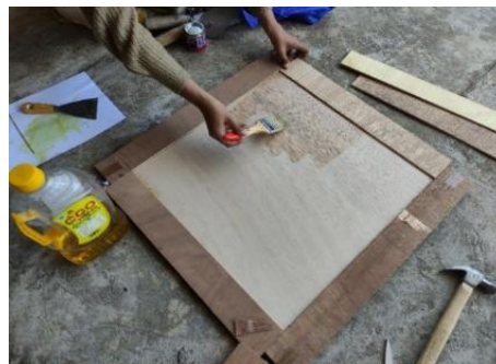
Gambar 3.16 Pemberian Minyak Pelumas Bekisting Plafond
