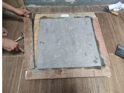
Gambar 3.21 Pelepasan Bekesting Plafond
