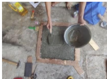
Gambar 3.20 Penuangan Adonan Terakhir Sampai Cetakan Penuh
