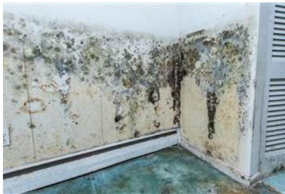
Gambar 2. 2 Dinding Berjamur Sumber : Dokumentasi Pribadi
