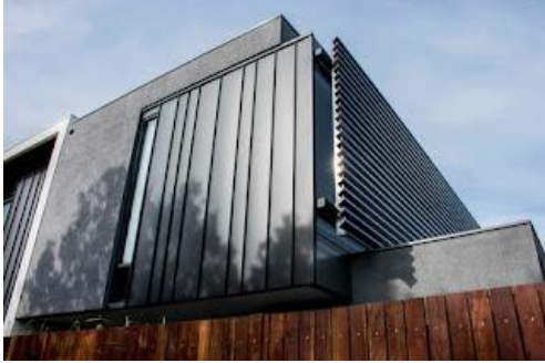
Gambar 2.- 2 Bangunan dengan fasade metal cladding
