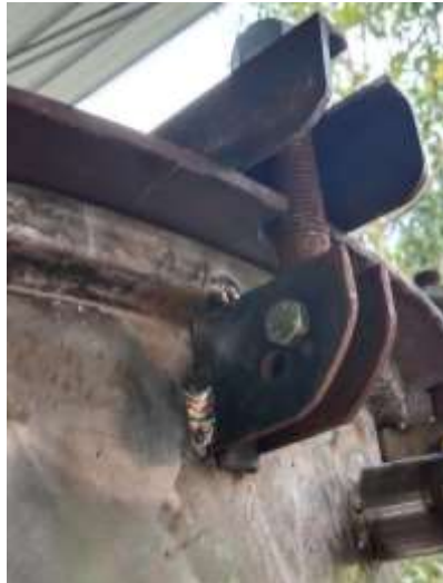
Gambar 3. 24. Pemasangan pengancing tutup ketel
