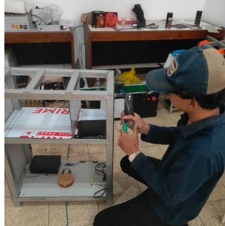
Gambar 3. 9. Pemasangan Cover ACP Menggunakan Paku Rivet
