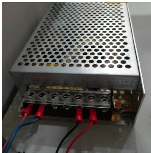
Gambar 3. 13. Pemasangan Power Supply 12VDC
