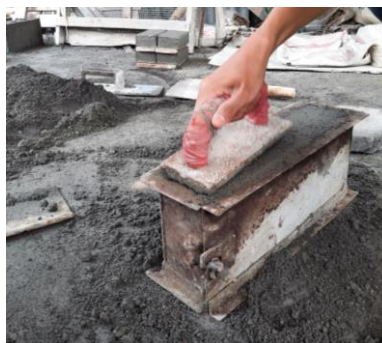
Gambar 3. 23 Proses Pemadatan Batako Konvensional Berongga
