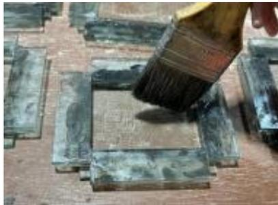
**Gambar 3. 22** Pengolesan Minyak Bekisting
